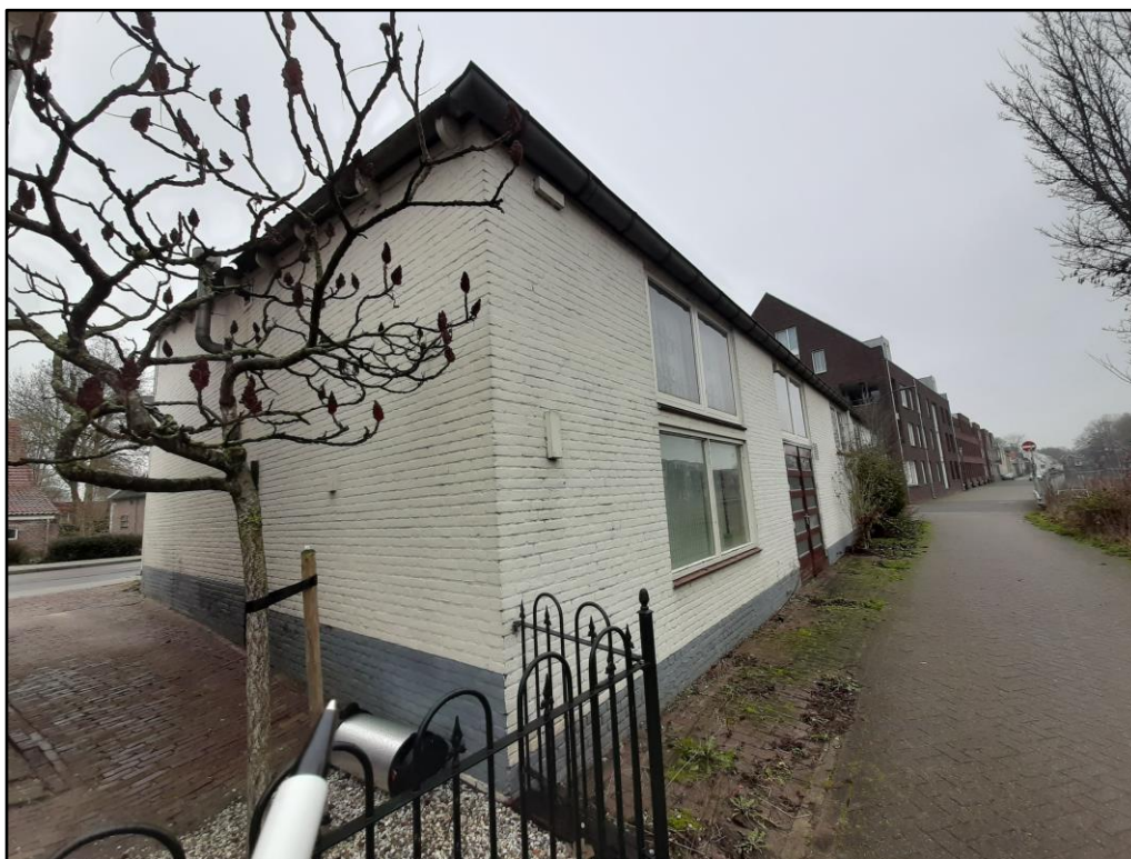
Figuur 2 De planlocatie gezien vanuit het noordoosten.
