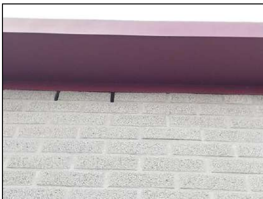
Afbeelding 3: Geschikte verblijfplaatsen voor vleermuizen in de vorm van open stootvoegen
