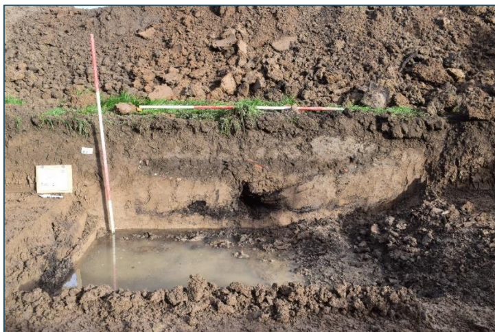
Afbeelding 8 Snel opkomend grondwater bij verdieping naar meer dan 1 m onder maaiveld. Bron: Vestigia2020.
