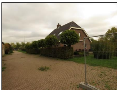
Figuur 11. Foto van het woonhuis nummer 14a, genomen vanuit het zuiden.
