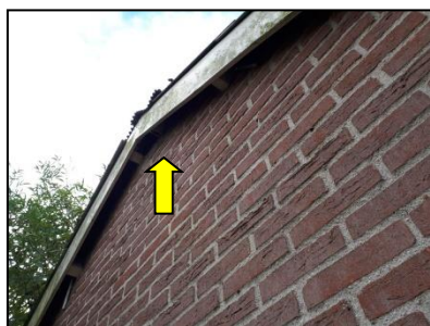
Figuur 13. Ruimte onder de kopgevel van nummer 14.
