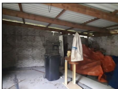
Figuur 31. Binnenkant oude schuur Hoogland nummer 7.
