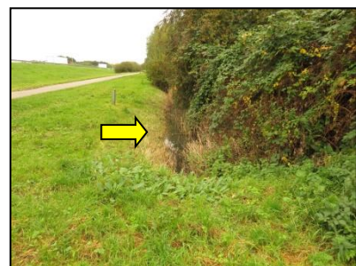
Figuur 44. Watergang bij ingang baggerdepot, foto vanuit noordelijke richting.
