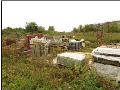
Figuur 22. Aanwezige bouwmaterialen deelgebied E.
