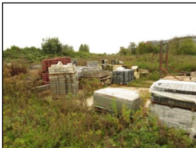
Figuur 22. Aanwezige bouwmaterialen deelgebied E.
