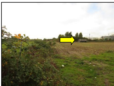
Figuur 16. Overzichtsfoto van de schuur, genomen vanuit het noorden.
