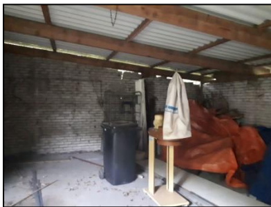
Figuur 31. Binnenkant oude schuur Hoogland nummer 7.
