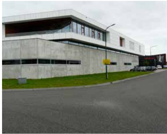
Representatieve zijde bedrijfsbebouwing aan de straat
