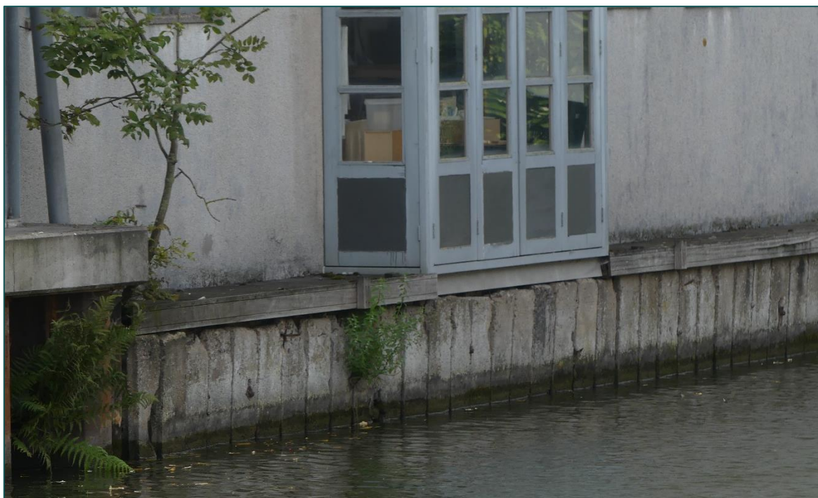
Figuur 3 De oever met de naastgelegen Hollandsche IJssel is volledig beschoeit en blijft in de beoogde ruimtelijke ontwikkeling behouden.
