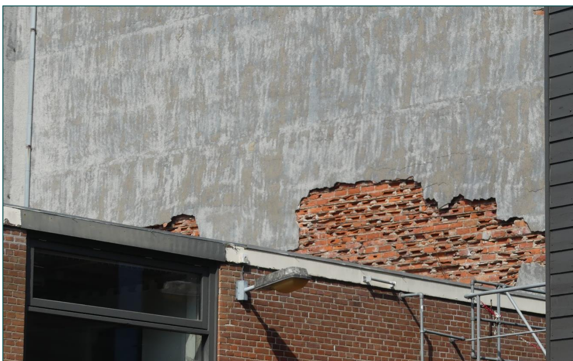
Figuur 2 De bebouwing bestaat uit gemetselde steens muren zonder spouw en een plat bitumen dak. Het silogebouw heeft afbrokkelende pleisterwerk aan de buitenzijde.
