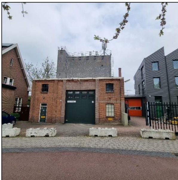
Afbeelding: aanzicht op het perceel Eiteren 18 te IJsselstein. Het voormalig silogebouw (grijs) is gelegen aan de achterzijde van het bestaande bedrijfsgebouw/voormalige graanmaalterij.
