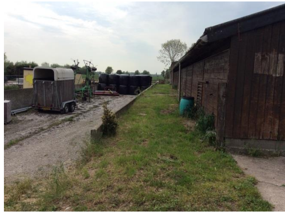
Figuur 8: Dak(goot) bebouwing
