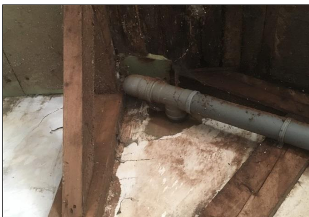
Pvc leidingwerk Niet asbestverdacht
