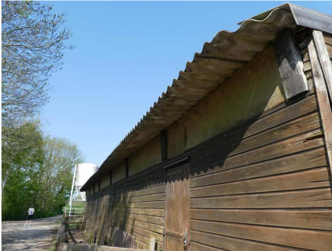
Figuur 8: Buitenzijde gebouw 4
