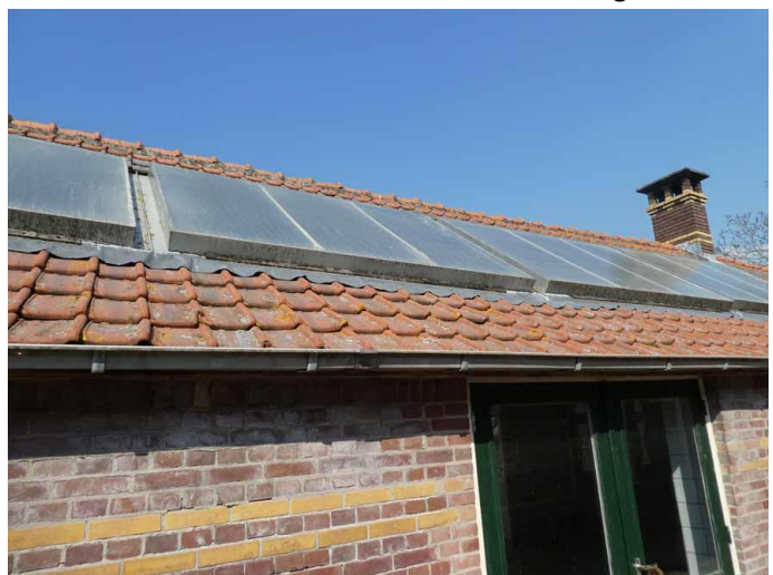
Figuur 6: Dak van gebouw 1 met strakke pannen en ramen
