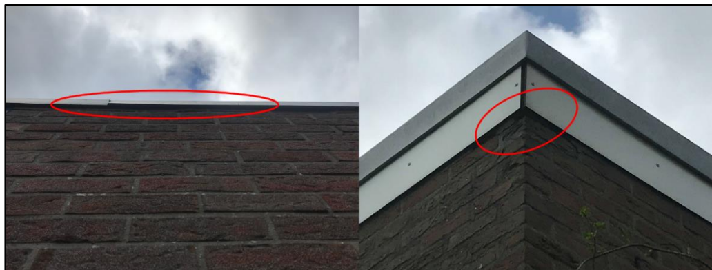
Figuur 1.3 Middels kierende daklijsten en open stootvoegen kunnen vleermuizen toegang krijgen tot potentiële verblijfplaatsen in de bebouwing op de planlocatie.
