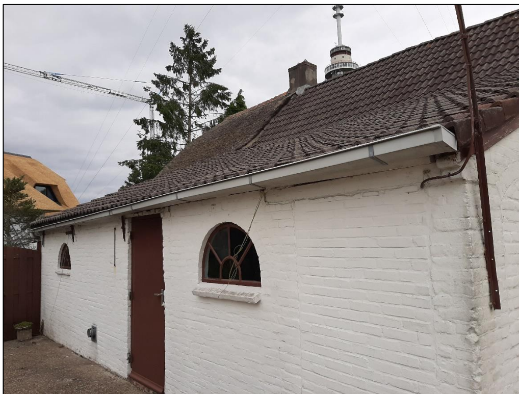
Figuur 1 De vrijstaande woning aan de Hogebeezendijk 82 te IJsselstein bestaat uit 2 delen waarvan één deel is opgetrokken uit een stenen muur met een zadeldak met dakpannen. Het andere deel is bedekt met een rieten dak.
