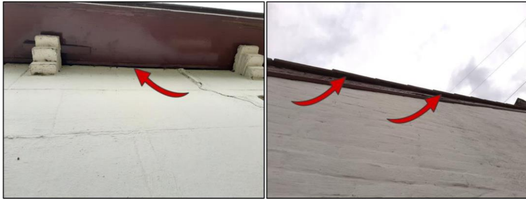
Figuur 1.3 Middels kierende kantpannen en openingen onder het overstek kunnen vleermuizen toegang krijgen tot binnenruimtes waardoor potentie voor vorengenoemde vleermuissoorten niet uitgesloten kan worden. Alleen de vrijstaande woning beschikt over potentie (Rebergen, 2020).
