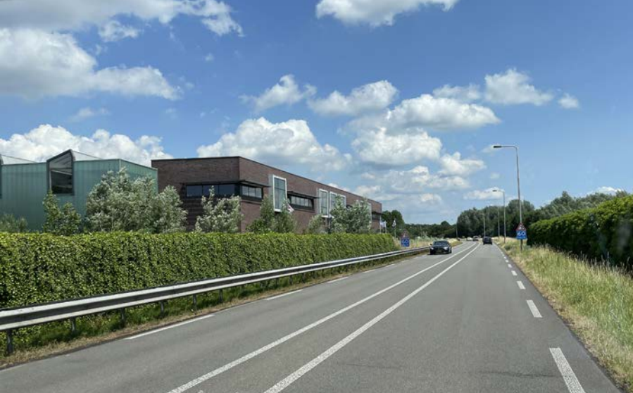
Doorzetten van bestaande gevelrooilijn aan de N210
