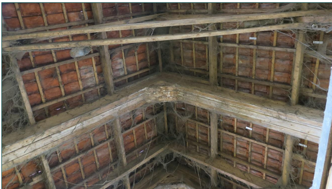
Figuur 3.2 Vanwege en afwezigheid van dakbeschot en verlichting is stal 9 een geschikte verblijfplaats voor de gewone grootoorvleermuis.
