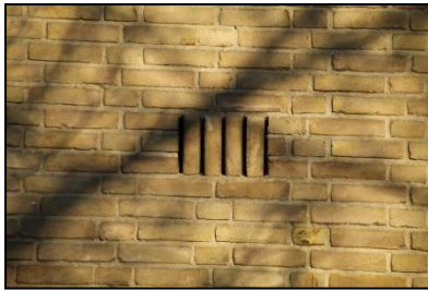
Figuur 14. Ventilatievoeg aan de zuidelijke zijde van het bijgebouw.
