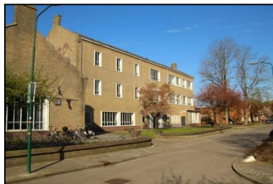
Figuur 3. Noordoostelijke gevel van het hoofdgebouw van de onderzoekslocatie.
