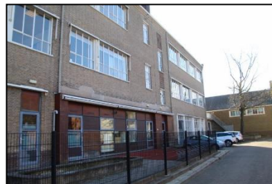
Figuur 5. Zuidwestelijke gevel van het bijgebouw van de onderzoekslocatie.
