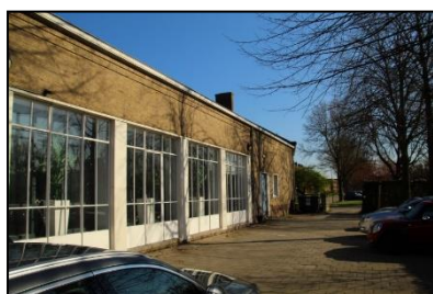
Figuur 6. Zuidelijke gevel van het bijgebouw, met daaraan aangrenzend een parkeerterrein.
