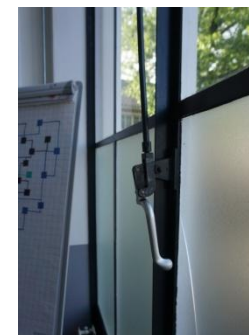
Oorspronkelijke ramen met hang- en sluitwerk
