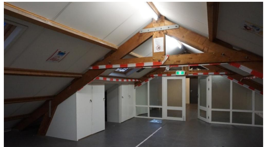
Spanten in het hoofgebouw
