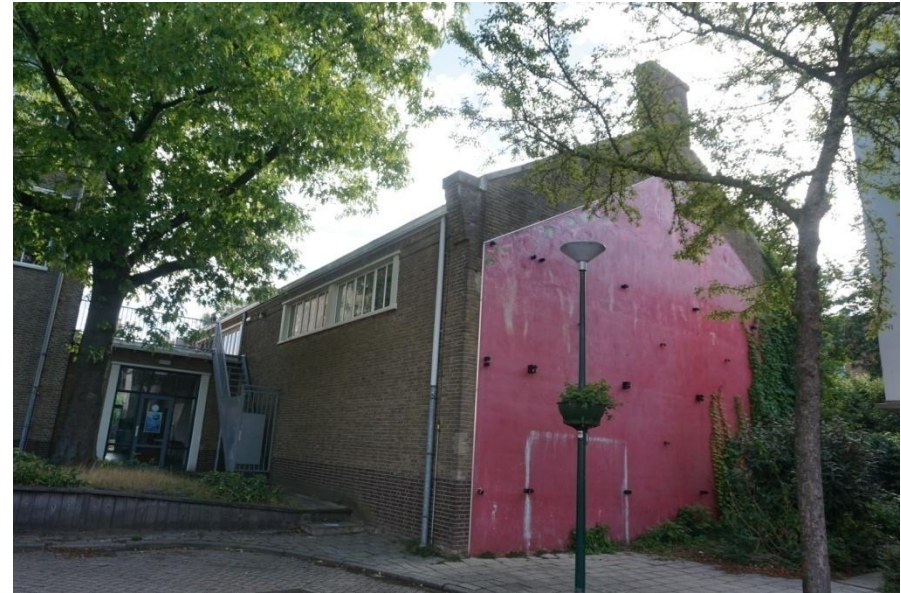
Rechter zijgevel en achtergevel van de dwarsvleugel
