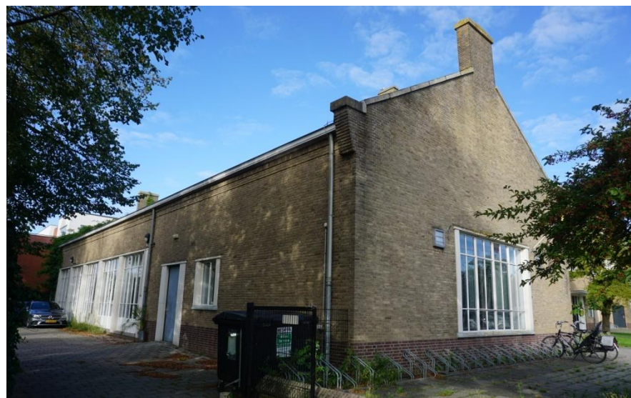
Voorgevel en linker zijgevel van de dwarsvleugel
