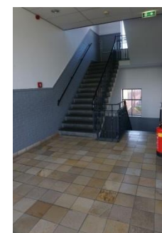
Oorspronkelijke vloer, trap en lambrisering op de 1 e verdieping
