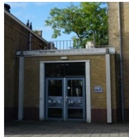
Voorgevel van het tussenlid
