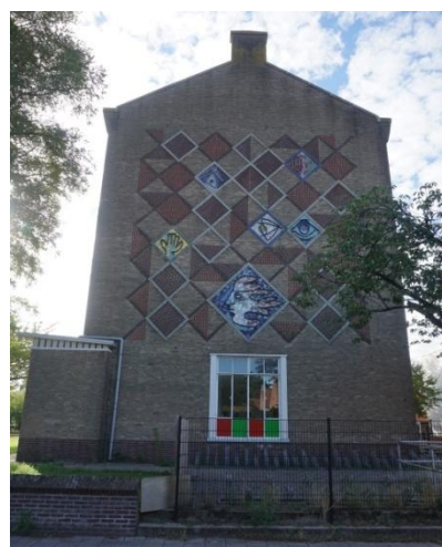
Rechter zijgevel van het hoofgebouw
