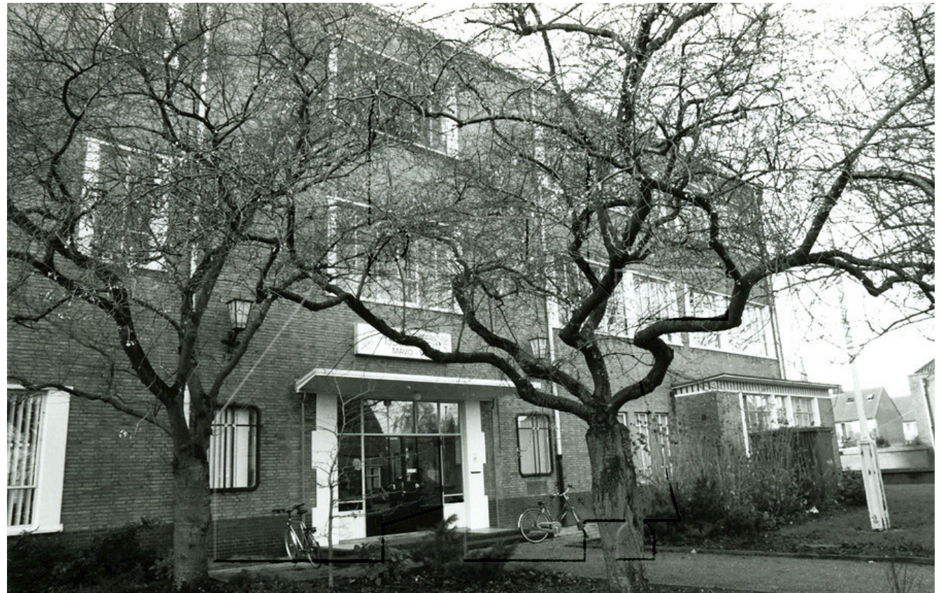
Zicht op voorgevel hoofdgebouw omstreeks 1997 (bron beeldbank HKIJ NL-IJssHKIJ-o8201)
