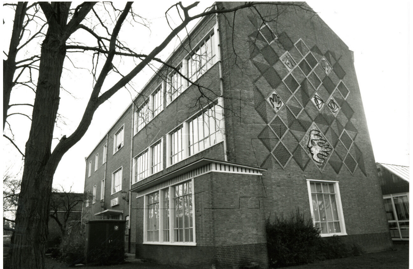
Zicht op voorgevel hoofdgebouw omstreeks 1997 (bron beeldbank HKIJ NL-IJssHKIJ-o8202)
