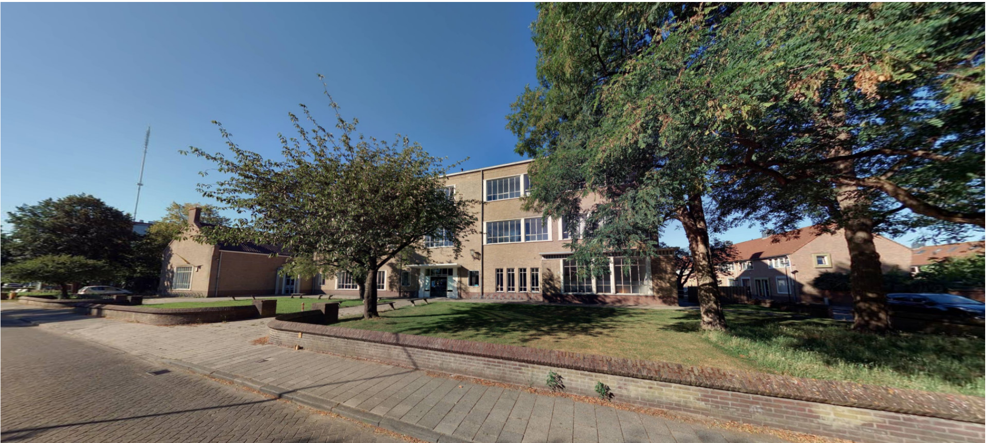
Waardevol ensemble: groene voorruimte, hoofgebouw en bijgebouw (gymgebouw)
