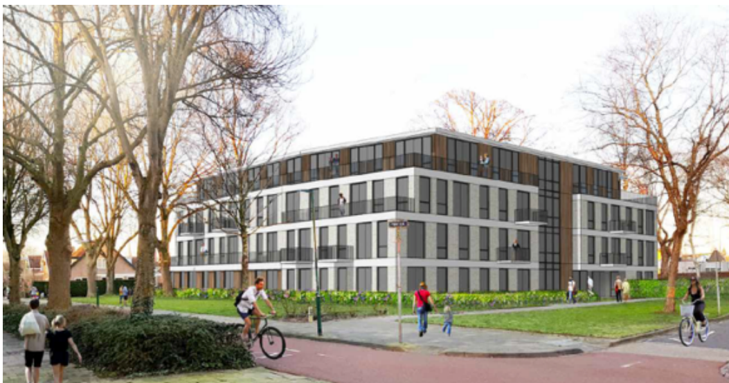
Impressie nieuwbouw d.d. augustus 2018.
