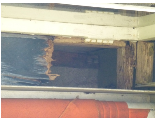
Openingen aan onderzijde kozijnen.
