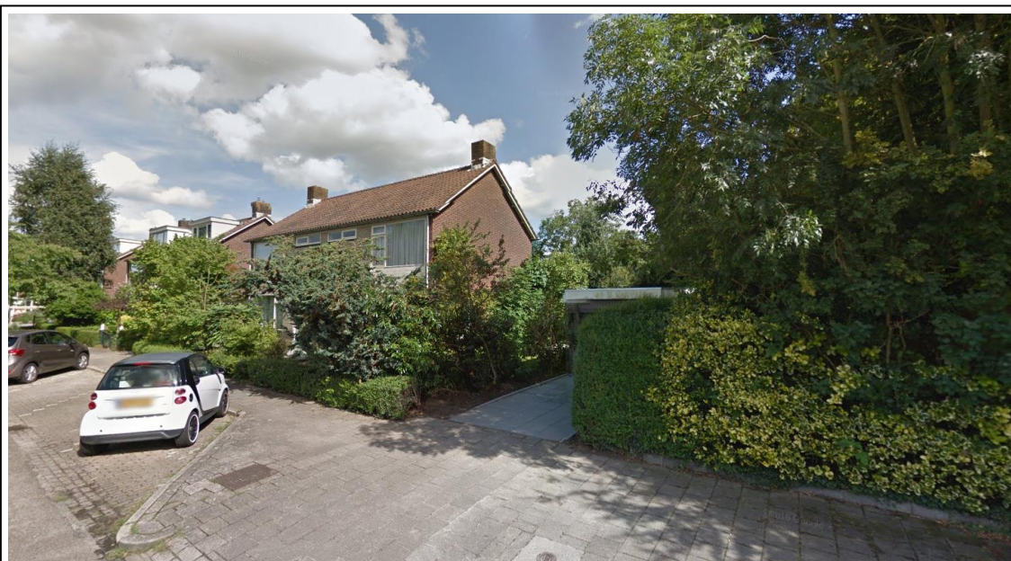
Figuur 7 – Foto van de bestaande garage binnen het plangebied, en de bestaande twee-onder-een-kapwoning op het perceel Prinses Irenelaan nr. 2 (bron: Google Streetview)
