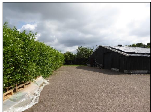
Te slopen schuur met zonnepanelen;
