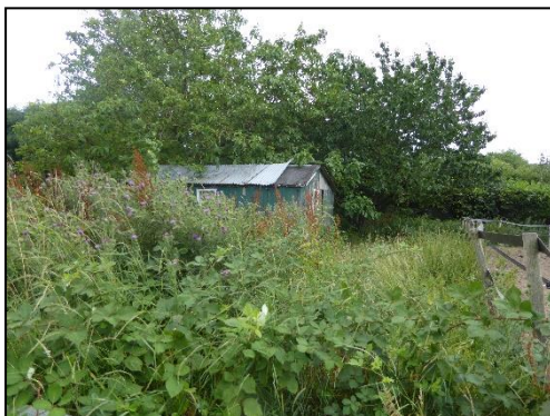
Vervallen schuur op noordwestelijke erf;
