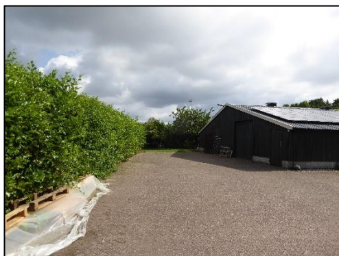
Te slopen schuur met zonnepanelen binnen deelgebied 2;
