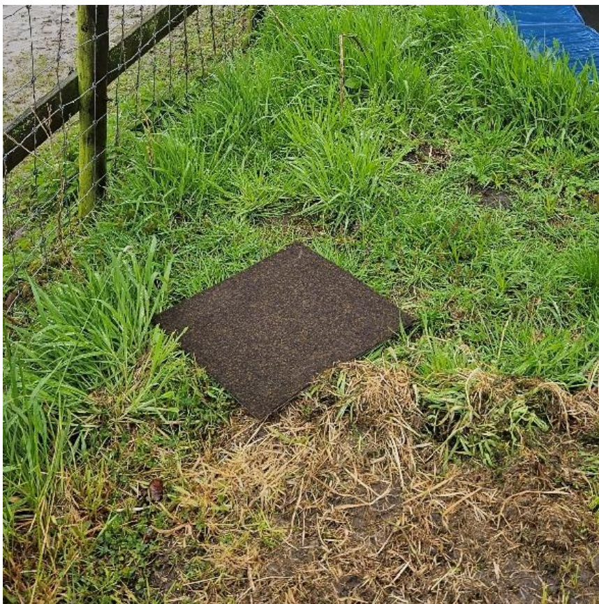
Voor de amfibieplaat zijn tapijttegels gebruikt
