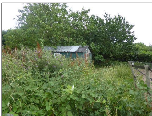
Vervallen schuur op noordwestelijke erf (deelgebied 1);
