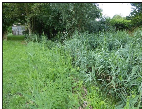
Afwateringssloot volgroeid met riet tussen noordoostelijke (2) en noordwestelijke (1) perceel;
