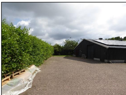
Te slopen schuur met zonnepanelen binnen deelgebied 2;
