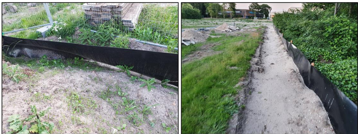
Figuur 3 Een incorrect geplaatst amfibiescherm (links). Een correct geplaatst amfibiescherm (rechts). Deze dienen minimaal 10 cm ingegraven te zijn. Bron foto's: Blom Ecologie B.V.
