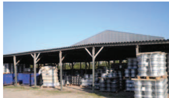
Foto 2 - Open opslagloods met asbest dakplaten
