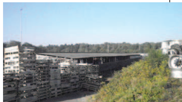
AMMOVEREN VAN ASBESTHOUDENDE OPEN LOODS (650M 2 )
