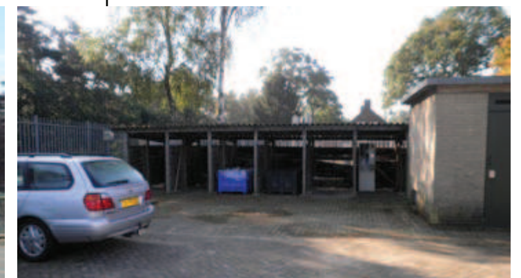
AMMOVEREN VAN ASBESTHOUDENDE FIETSHOK (40M 2 )
