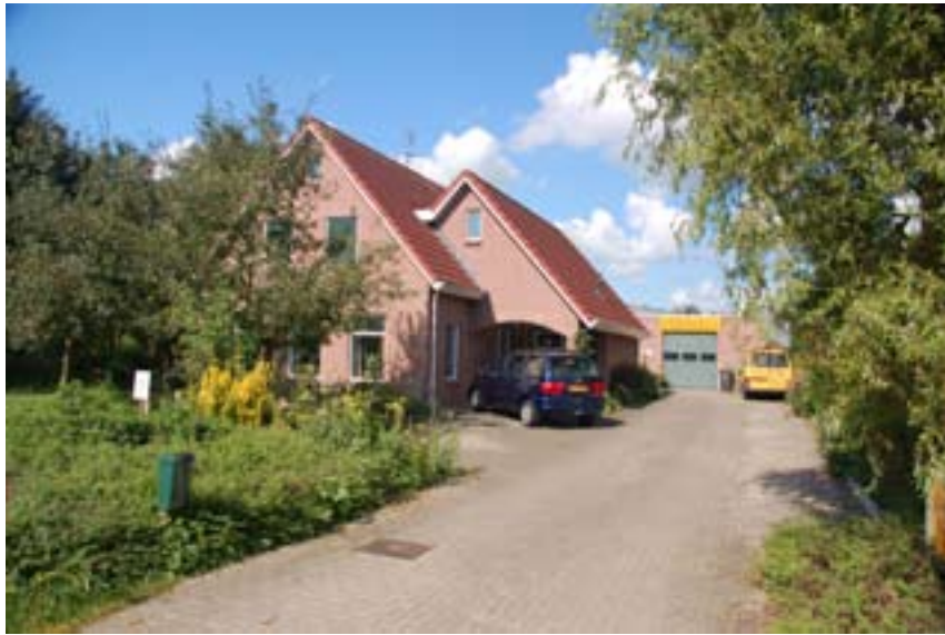
Bedrijfsbebouwing achter woning, geheel in baksteen gelijk aan woning
