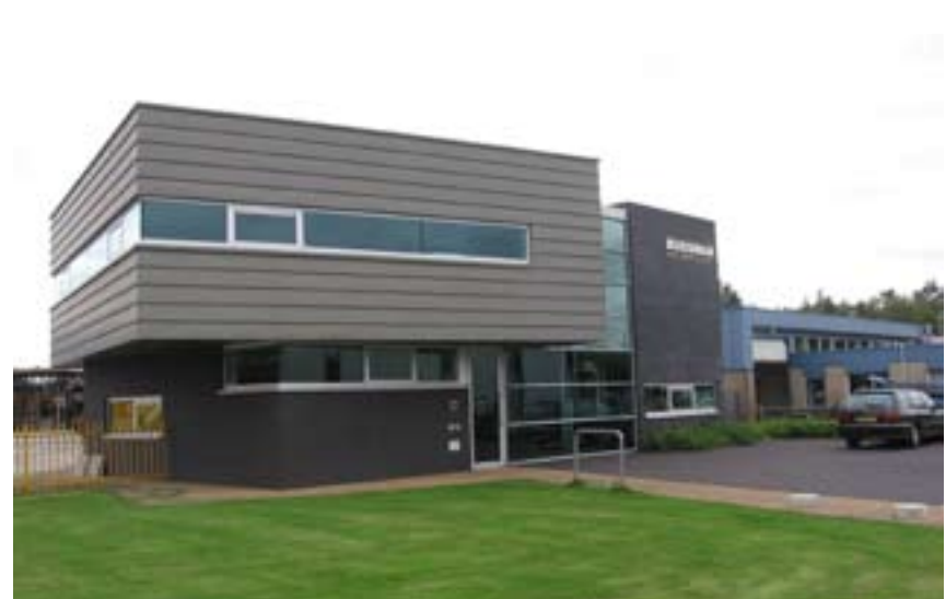
Solitair bedrijfsgebouw met baksteen en zilverkleurig plaatmateriaal
