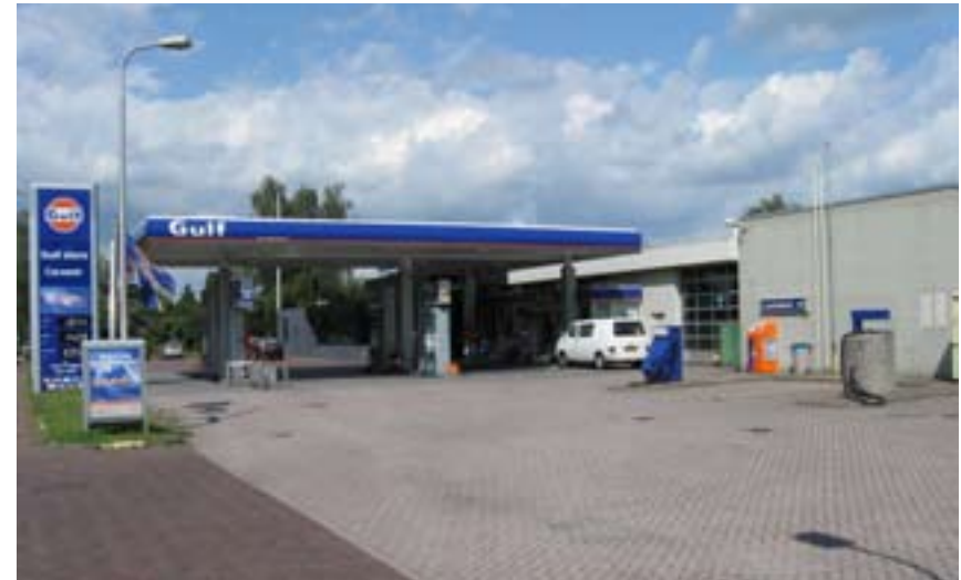
Het tankstation met garage aan de Mgr. Borretstraat
