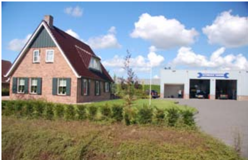
Bedrijfsbebouwing achter woning met bakstenen plint gelijk aan baksteen woning
