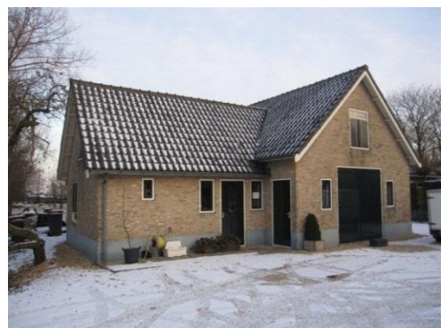
Figuur 4: Bestaand bedrijfsgebouw
