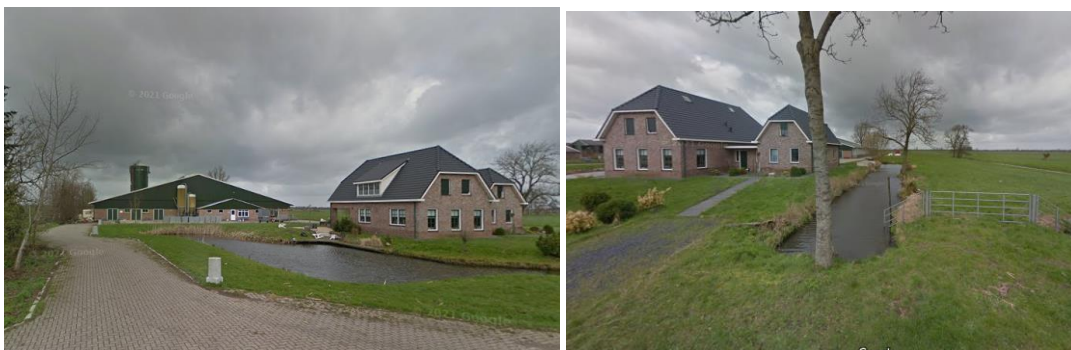
Figuur 3 bestaande situatie vanaf zuidwestelijke -(links) en zuidoostelijke (rechts) zijde
