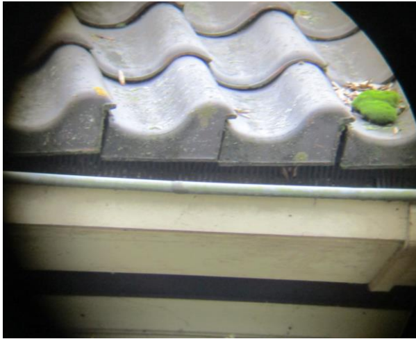
Figuur 5 Onder de eerste rij dakpannen is vogelschroot bevestigd.
