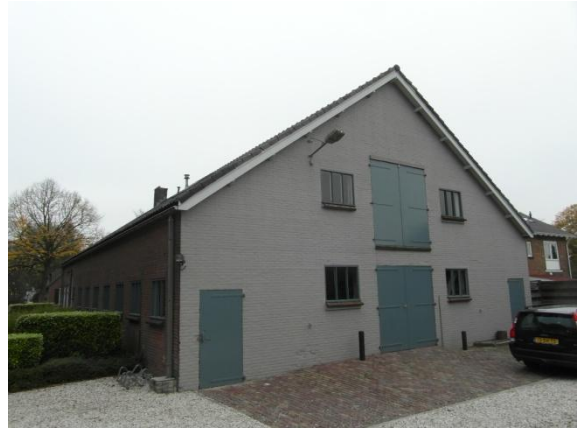
de huidige achtergevel
