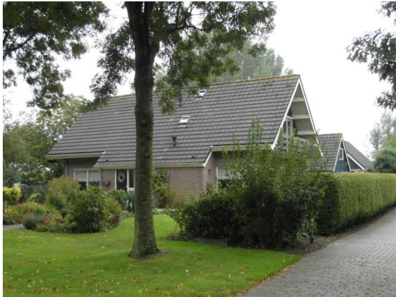
de moderne woning links bepaalt het beeld vanaf de straat
