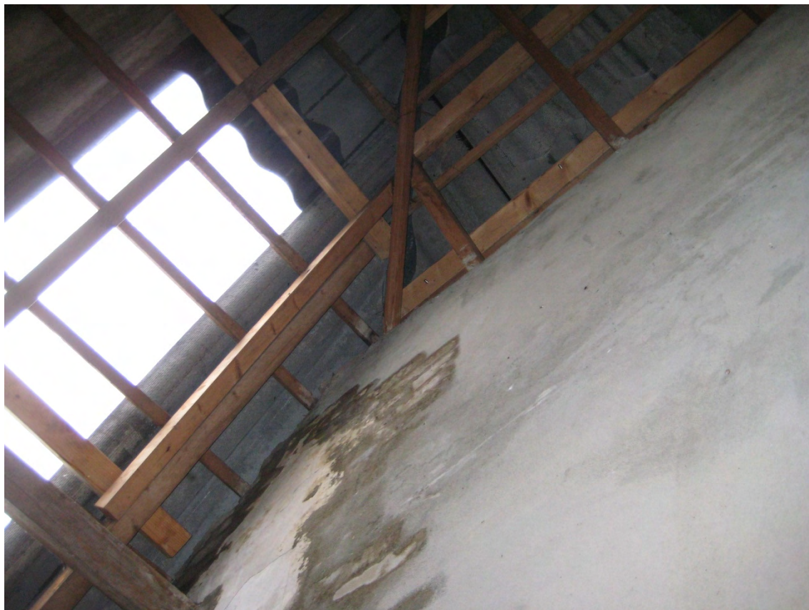
Dakbedekking met licht doorlatende platen
