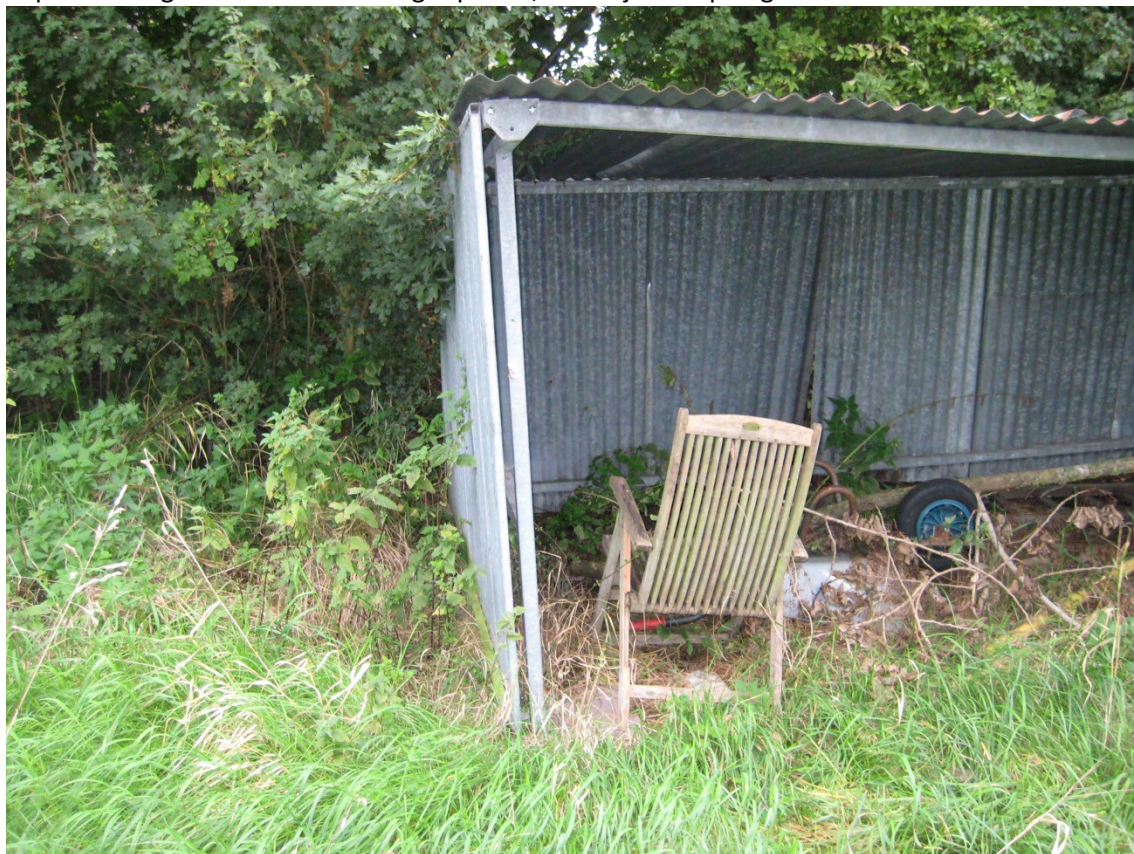
Kapschuur afgewerkt met blikken golfplaten, zuidelijk deel plangebied
