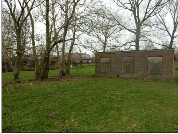
Rechts de te amoveren kippenschuur / links de woning
