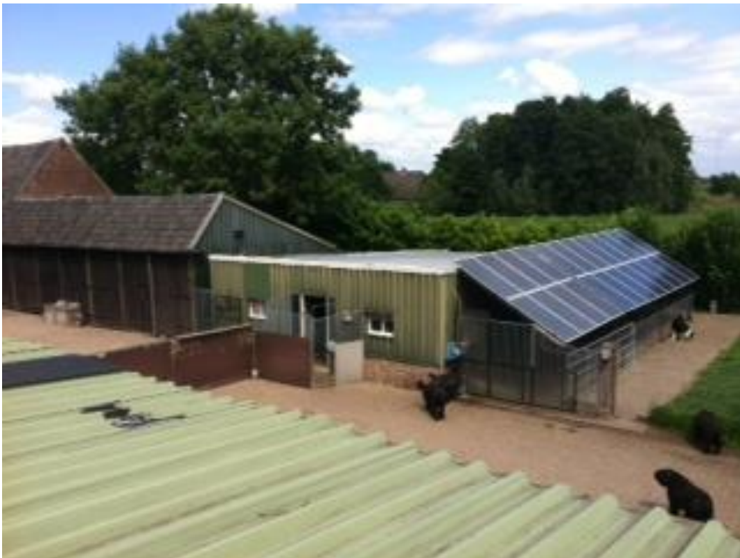
Foto schuren C, G en H (deze schuren worden vervangen door nieuwbouw)
