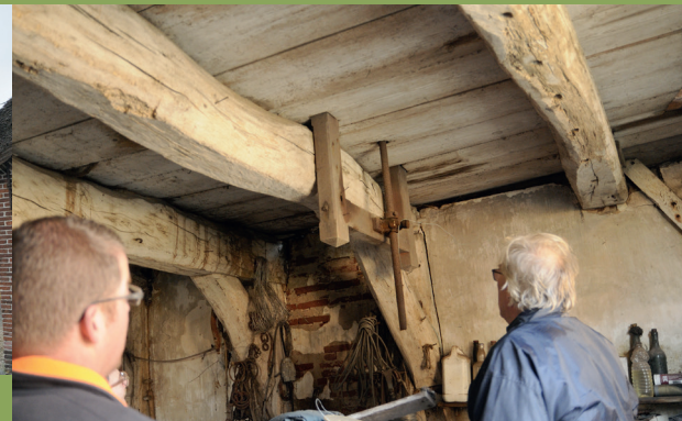
Originele grote karmolen met zware constructie aanwezig.
