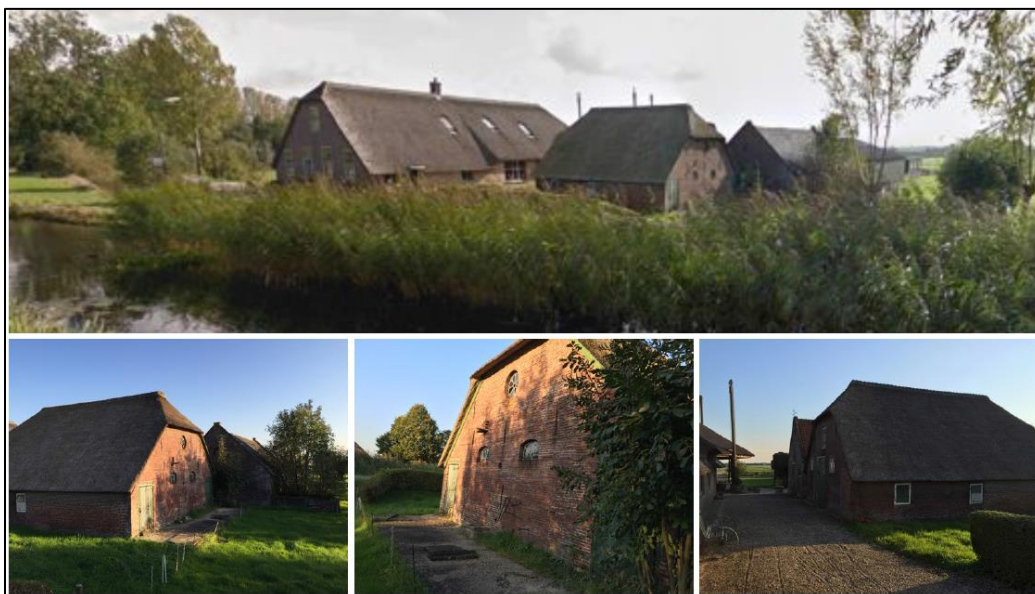
Figuur: Bestaande bebouwing (Bron: Verstoep Bouwkundigen)
