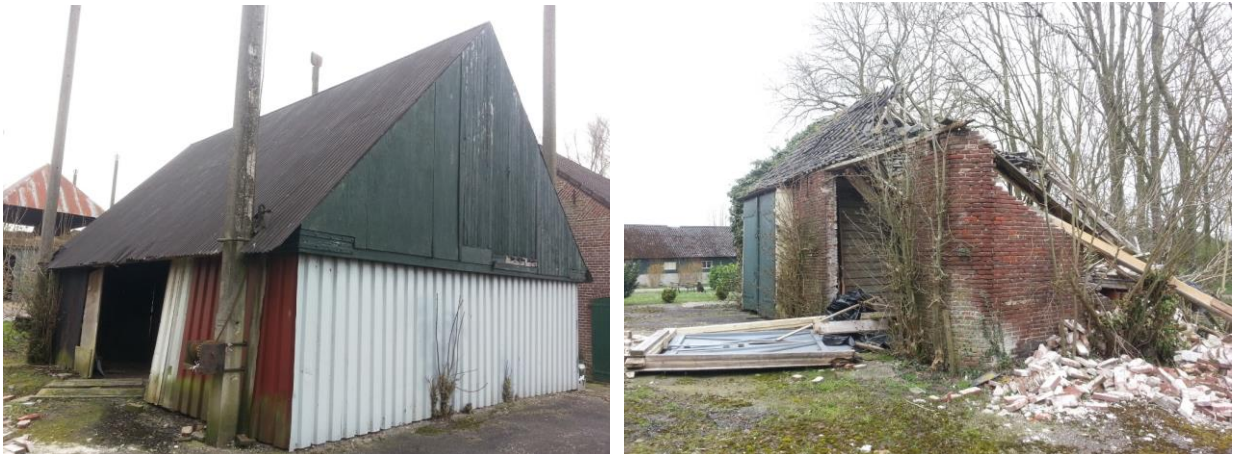
Figuur 5: de voormalige hooiberg (links) en het vervallen stenen schuurtje (rechts).
