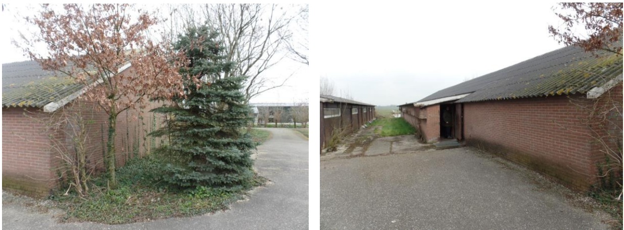
Figuur 6: Buitenzijde voormalige varkensstal.
