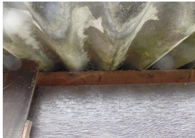
Figuur 11: Links: inspectie dakrand van de varkensstal. Rechts: dakrand met gaas bij de houten schuur (f).
