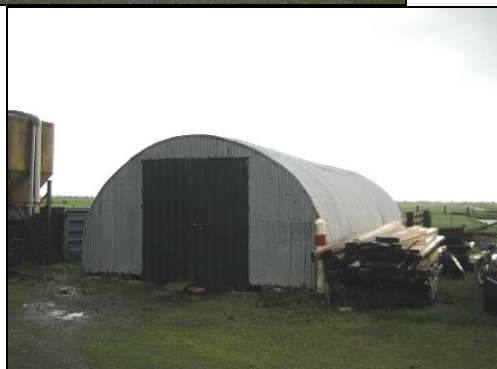
Impressie van enkele opstallen in het plangebied (SAB, 2013)
