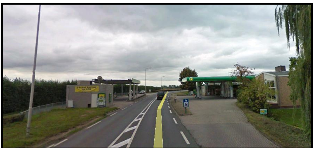
De 'flessenhals' van het pompstation vanuit het noorden.
