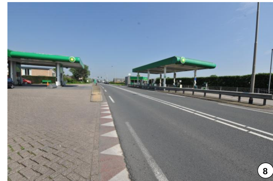
Aanzicht vanuit zuidelijke richting op tankstation
