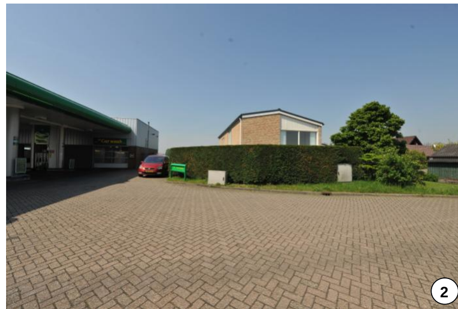
Naastgelegen woning grenzend aan tankstation
