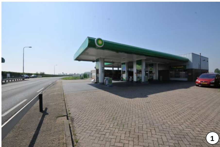
Tankstation aan M.A. Reinaldaweg
