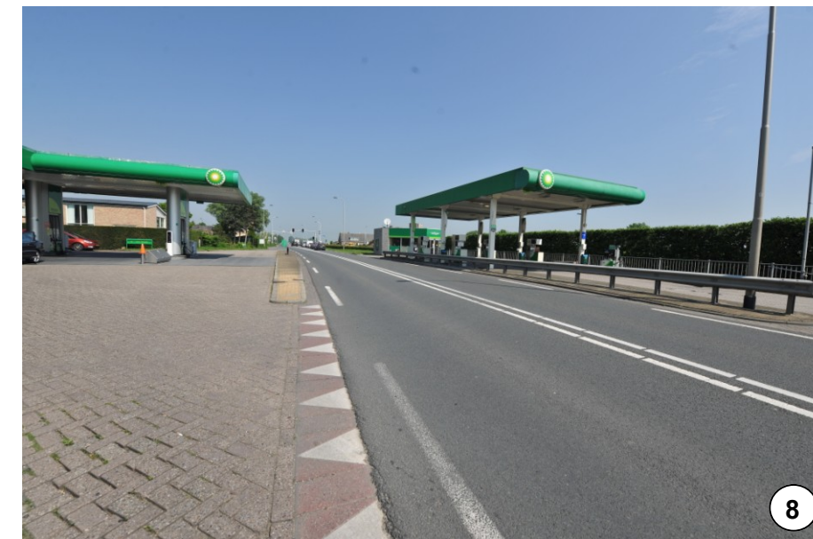
Aanzicht vanuit zuidelijke richting op tankstation
