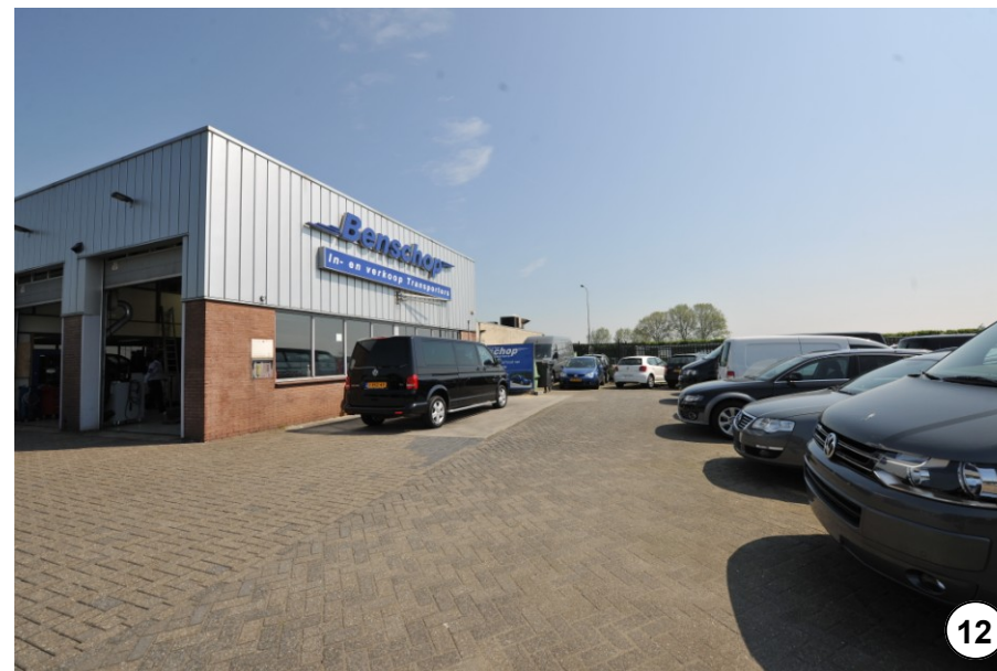
Voorzijde bedrijfshal met bedrijfsterrein autoservice Benschop
