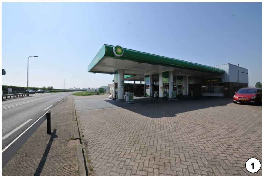
Tankstation aan M.A. Reinaldaweg
