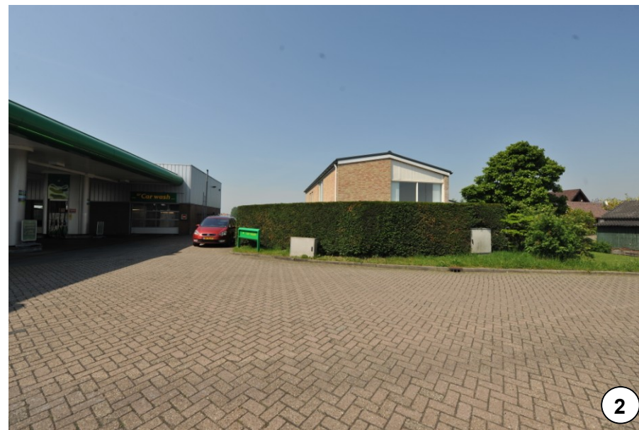
Naastgelegen woning grenzend aan tankstation
