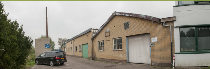
De locatie is een samenvoegsel van allerlei bedrijfsgebouwen waarbij elke vorm van samenhang ontbreekt.
