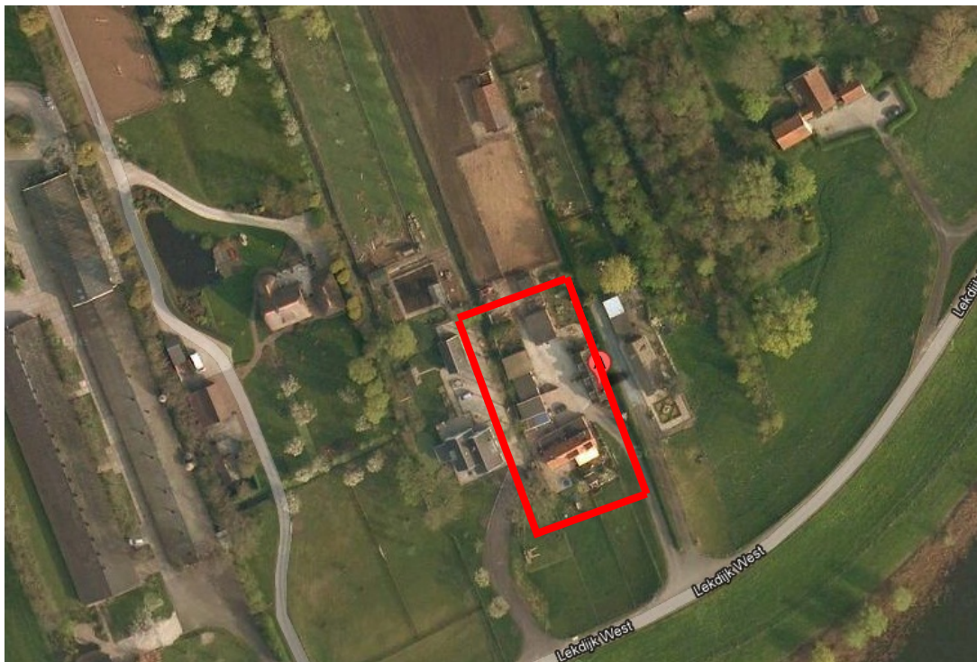
afb. 1: Luchtfoto; bron: Google Maps
