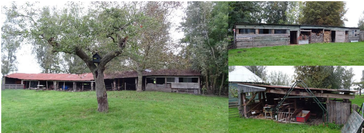
Figuur 5: Impressie te slopen bijgebouwen op het perceel (bron: QuickScan flora en fauna Lekdijk West 13, Lopik).
