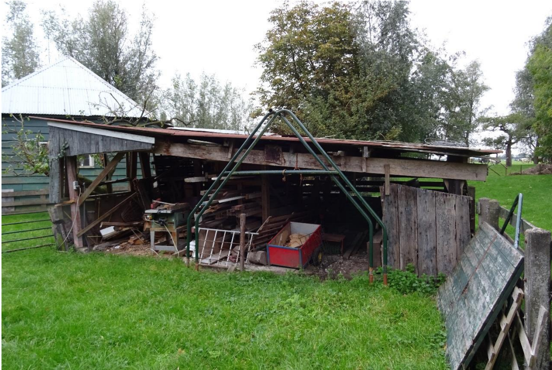
Afbeelding 3, 4 en 5: de te slopen opstallen. Bron: Rik Bijvelds. Datum: 16-10-2020
