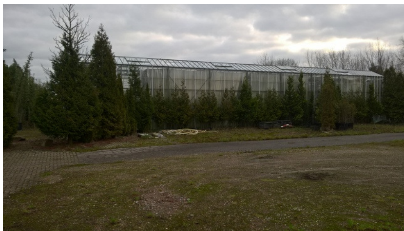
Foto 1: noordelijk gedeelte planlocatie (vanaf westzijde)
