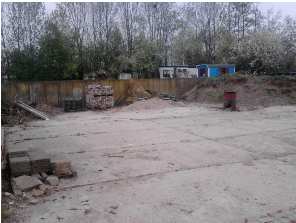
Figuur 7 Betonnen mestplaat aan de westkant van het perceel.
